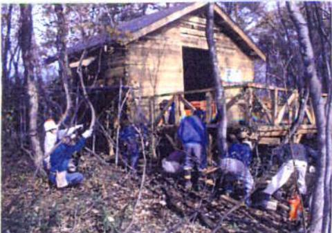
15ton油圧ジャッキ6台で家ごと浮かせる大工事
